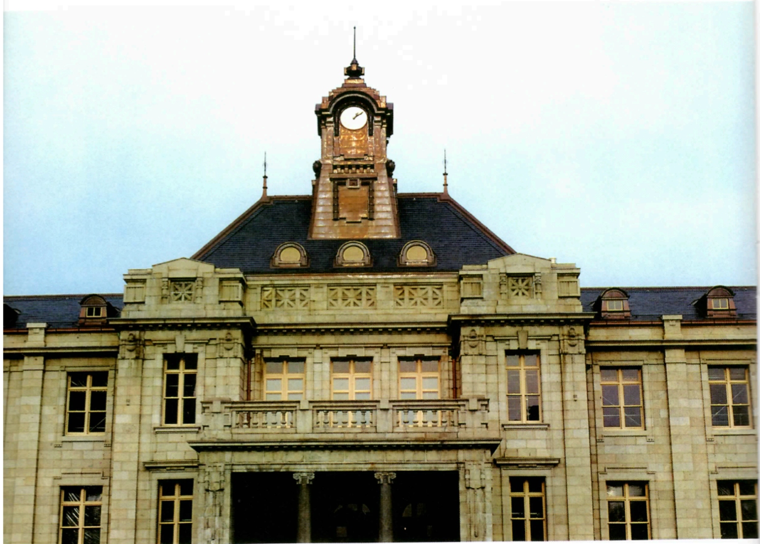
山形県郷土館・文翔館（旧山形県庁舎）
